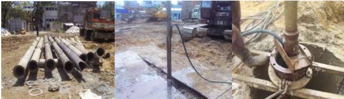
ống Tremie, ống thổi rửa và lắp ống thổi rửa hố khoan
